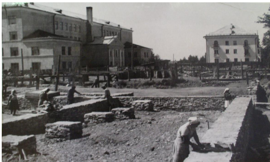
Строительство гостиницы «Абакан» и жилого дома, 1953г.
