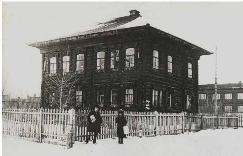
Здание Хакасского областного аэроклуба. Черногорск, 1930-е годы.
